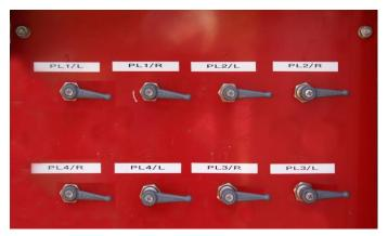
Der Steuerungskasten der Beregnungsanlage für die Plätze 1-4 befindet sich auf dem Weg zu Platz 3+4 am Treppensockel links vor Platz 2. Durch Drehen des Wasserhahnes um 45° im Uhrzeigersinn werden die entsprechenden Düsen Rechts oder Links des gekennzeichneten Platzes (PL) aktiv. Bitte jeweils nur einen Hahn betätigen, da sonst der verringerte Wasserdruck nicht ausreicht.
